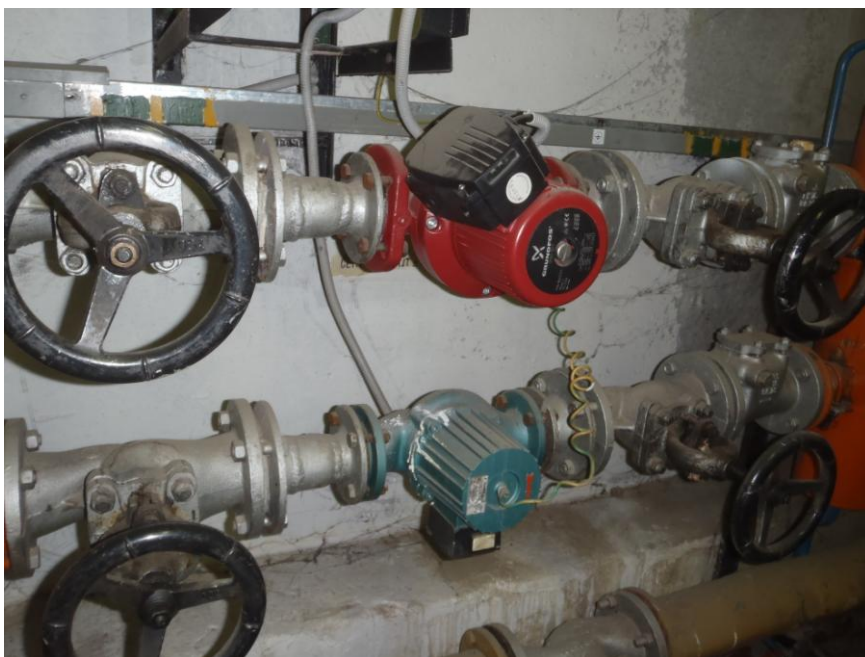
Obr.3 – Oběhová čerpadla pro ústřední vytápění obou topných větví
