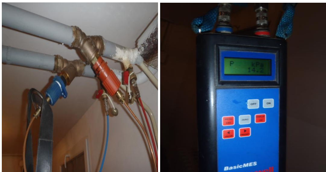
Obr.8 – Měření tlakové difference topné vody v tlakově nechráněné oblasti
